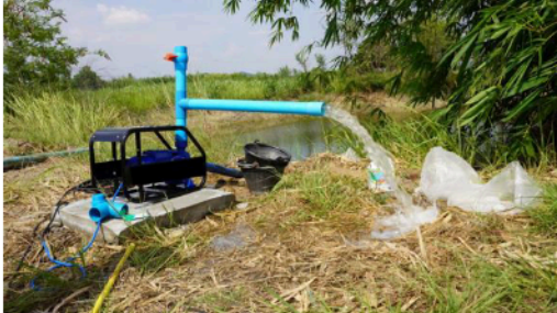
ภาพที่ 12 งานติดตั้งปั้มน้ำหอยโข่ง
