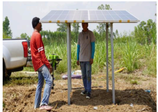
ภาพที่ 11 งานติดตั้งแผงเซลล์แสงอาทิตย์
