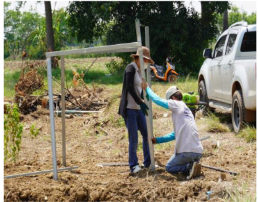
ภาพที่ 10 งานติดตั้งโครงสร้างรองรับแผงเซลล์แสงอาทิตย์
