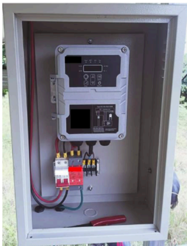
ภาพที่ 13 งานติดตั้งตู้ควบคุม
