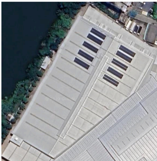
ภาพที่ 2 การติดตั้งแผงเซลล์แสงอาทิตย์บนหลังคา การติดตั้งอินเวอร์เตอร์ และระบบกักเก็บพลังงาน ดังแสดงในภาพที่ 3
